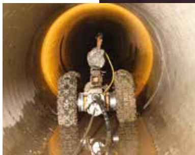
Inspection du réseau par une caméra autotractée et pivotante
