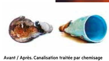
Avant / Après. Canalisation traitée par chemisage
