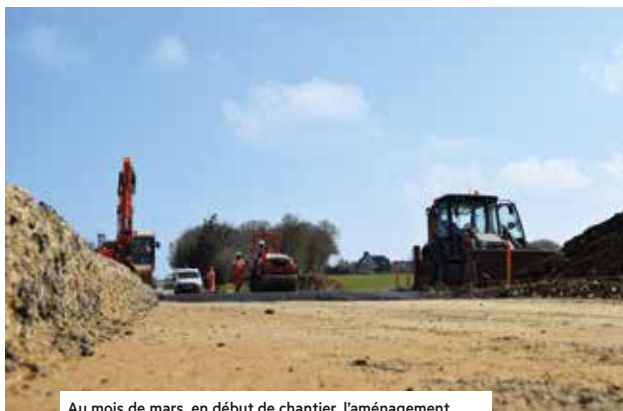
Au mois de mars, en début de chantier, l'aménagement du carrefour des Prés Mario a nécessité un décaissement de la voie avant empiérement et pose des couches successives (fondations et revêtement de surface).
